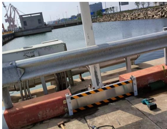
码头前沿排水孔封堵
